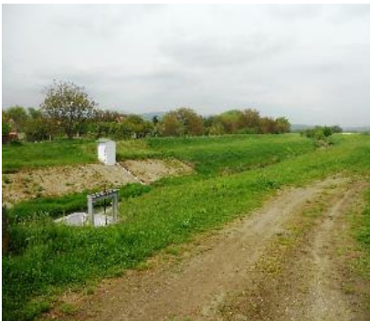
a Tarna híd környezete
